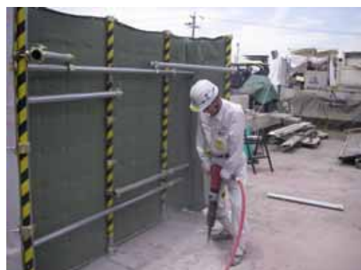
防音シート組み立て内部状況
