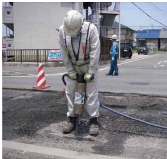
路上工事等の取り壊し作業に使用する小さな道具ですが、仕事中は誰にも負けない大きな音で多くの方に迷惑をお掛けする、極めて環境負荷の高い道具であるエアー ブレイカーの排気騒音を低減させる装置です。
