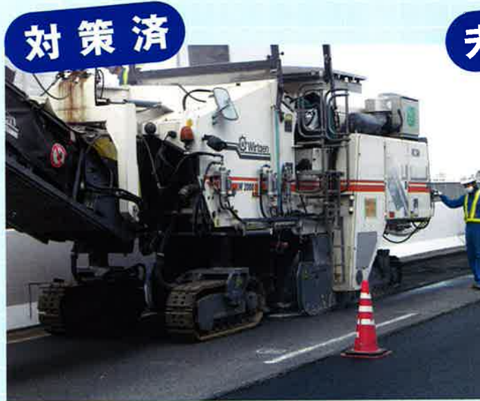
■粉塵対策をした施工
